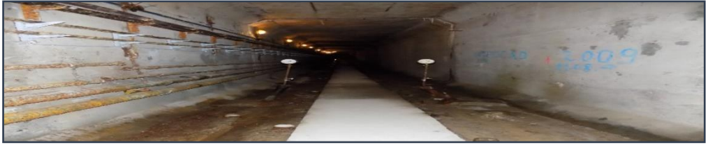
Figura 3 Galerie de injecții.
