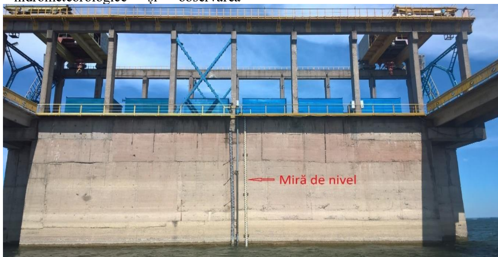
Figura 1 Miră pentru măsurarea nivelului apei în lacul de acumulare Costești – Stînca
